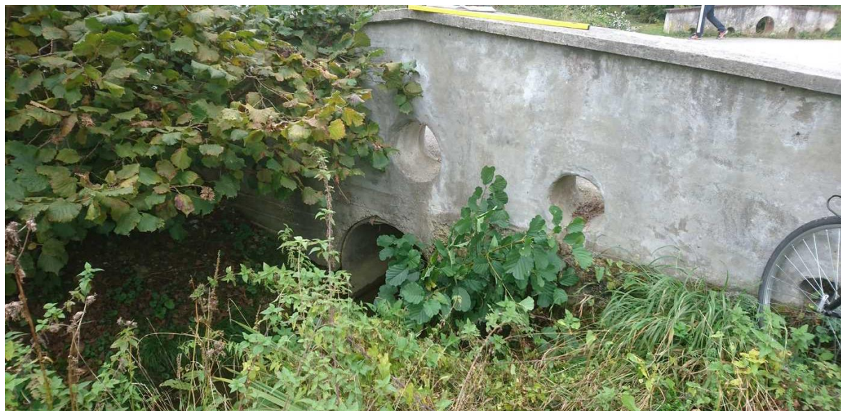
Slika 38: Prikaz obstoječega prepusta na lokaciji gostišča Trzinka (cev premera 1 m)
