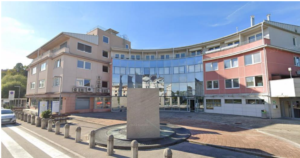
Slika 4-1: Prikaz obstoječega stanja
