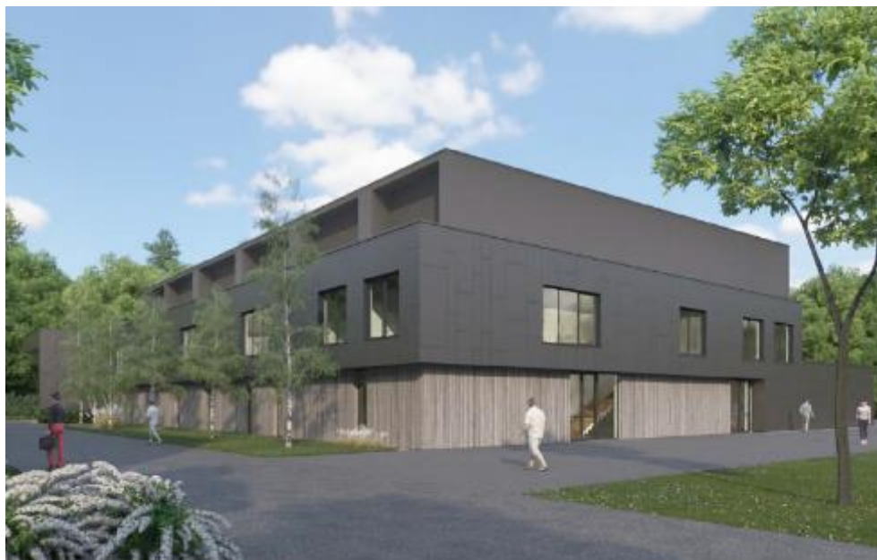
Slika 7.4: Severna fasada športne dvorane
