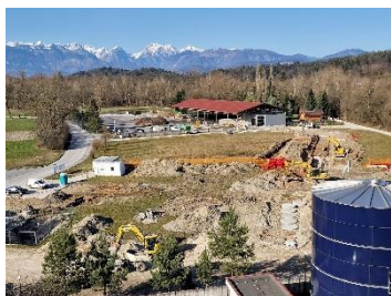
Slika 2: Začetek gradnje novega objekta za sušenje blata, ki ga je za CCN Domžale-Kamnik izvajalo ljubljansko gradbeno podjetje RIKO. (Foto: arhiv RIKO d.o.o., marec 2025)
